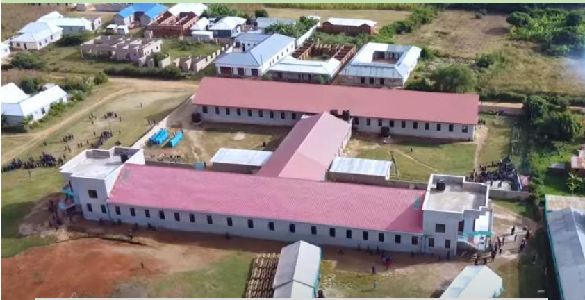
Blick auf das LEA Ministry Dormitory – das größte Gebäude im District Mbulu
