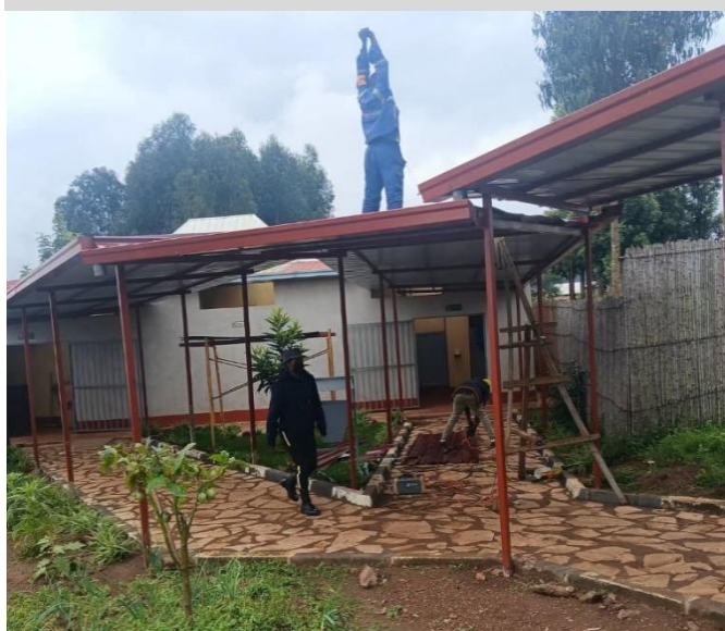
Neue Überdachung des Weges zu den Toiletten
