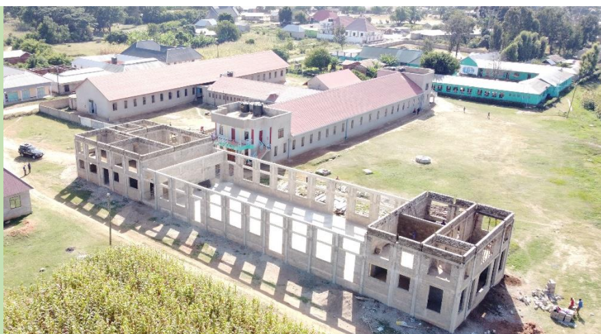
Neuer Speisesaal im Rohbau – dahinter die Schlafsäle und die LEA Grundschule
